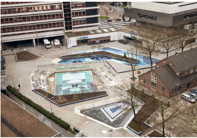
Skateplatz bei Sonnenschein – Wasserspeicher bei Regen: Not und Tugend im niederländischen Rotterdam
